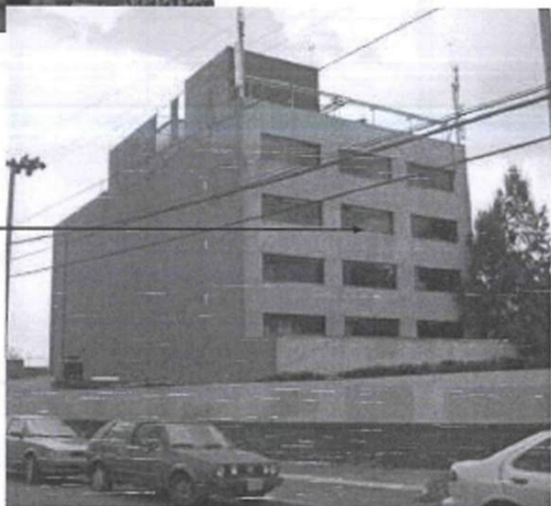
Figura 2 Vista de las fachadas anterior (principal) y posterior del edificio
